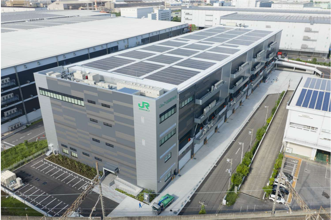
【物流施設外観】
