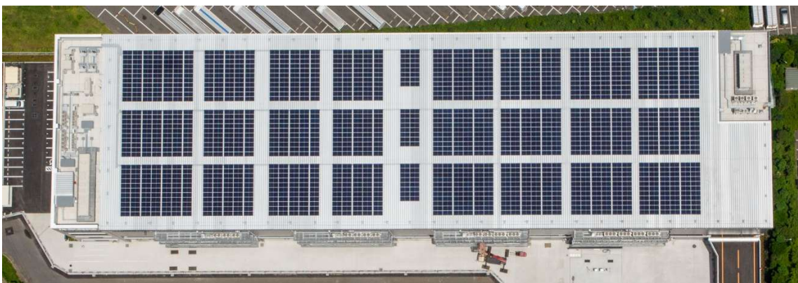
【屋根設置太陽光発電所】
